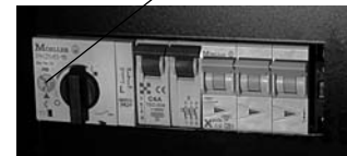
Nastavení tepelné ochrany motoru
